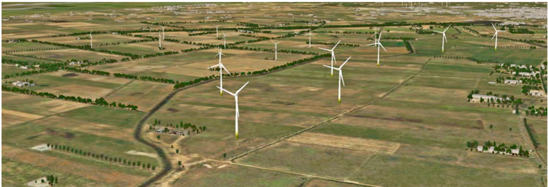
Windturbines in een zwermpstelling
